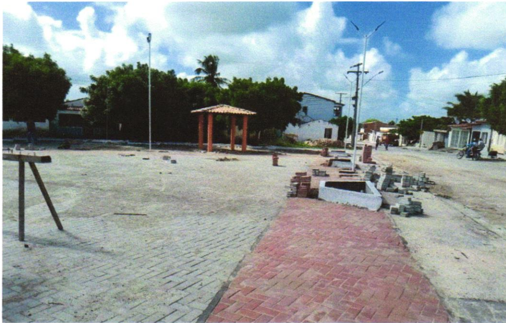
Foto 09 - Pavimentação em bloco de concreto vibroprensado, intertravado, cor natural, 10x20cm, e=6cm, 46un/m 2 , NBR9781, Fck(min)=35MPa, sob coxim areia grossa compactada c/ placa vibratória, e(comp.)=6cm, rejuntado c/ areia fina.
