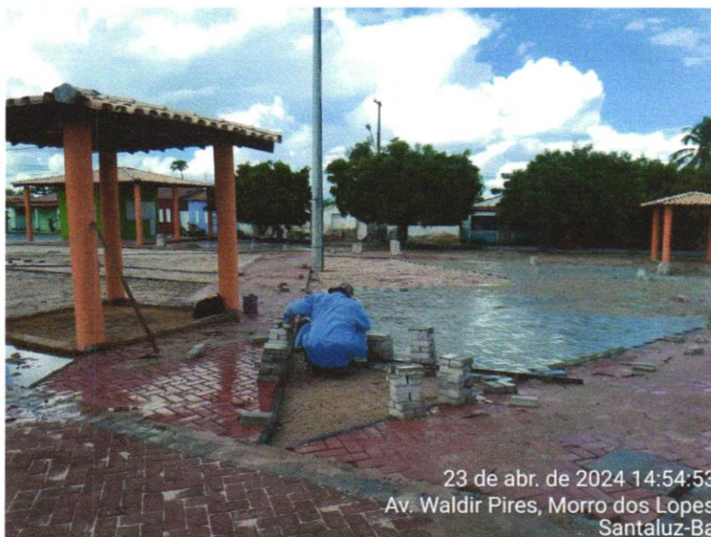
Foto 08 - Pavimentação em bloco de concreto vibroprensado, intertravado, cor natural, 10x20cm, e=6cm, 46un/m 2 , NBR9781, Fck(min)=35MPa, sob coxim areia grossa compactada c/ placa vibratória, e(comp.)=6cm, reuntado c/ areia fina.
