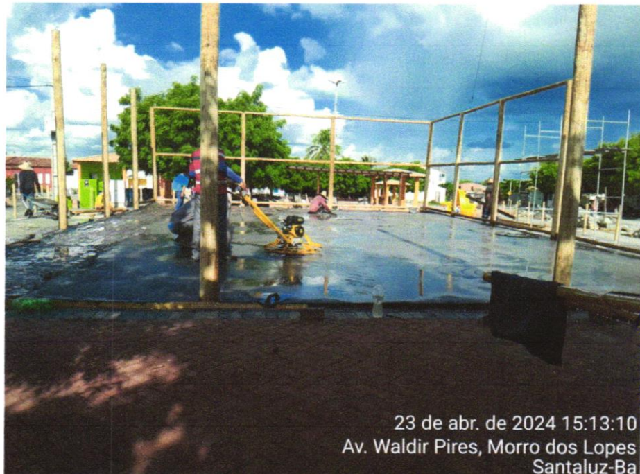
Foto 11 – Pavimentação em bloco de concreto vibropressado, intertravado, colorido, 10x20cm, e=6cm, 46un/m 2 , NBR9781, Fck(min)=35MPa, sob coxim areia grossa compactada c/ placa vibratória, e(comp.)=6cm, rejuntado c/ areia fina.
