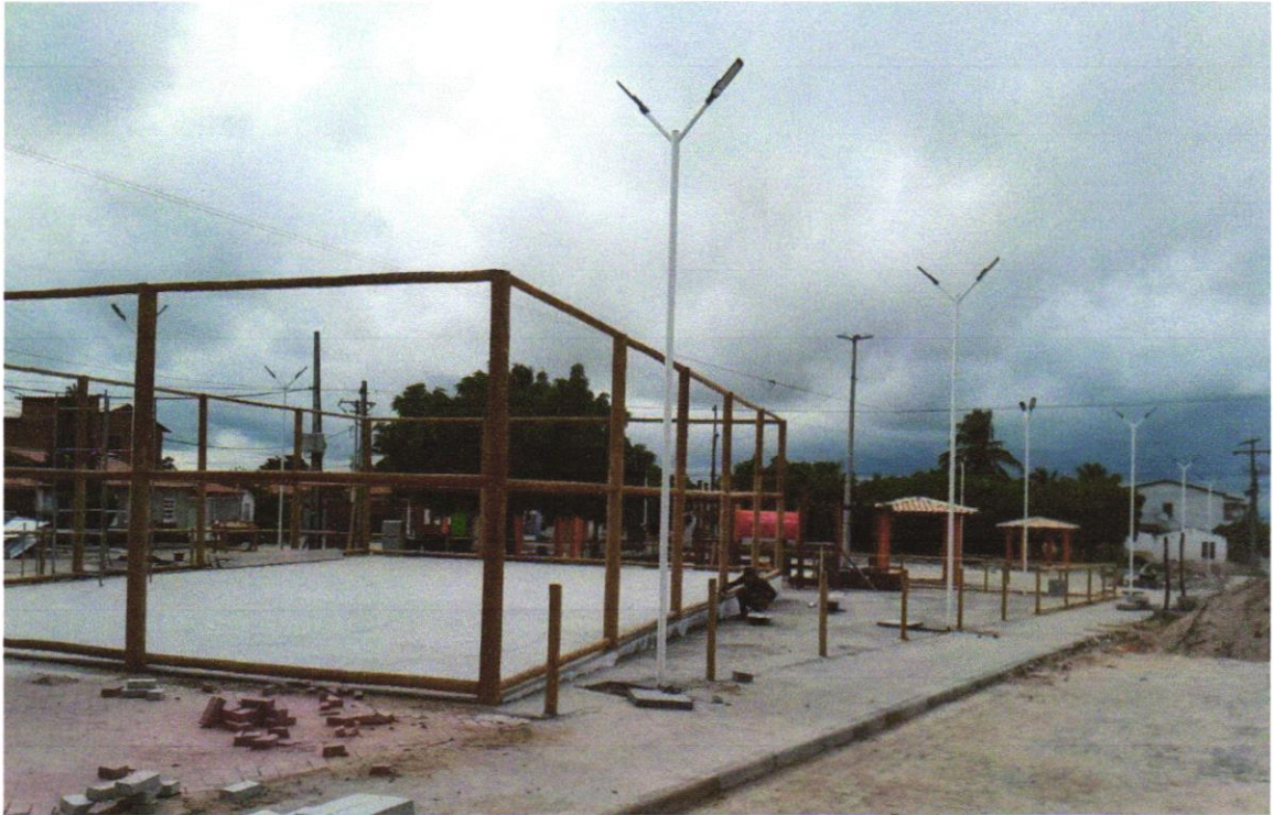
Foto 17 - Poste decorativo 2 pétalas, em aço galvanizado com difusor em vidro transparente temperado, com 3m/4m, inclusive lâmpada de led 50w
