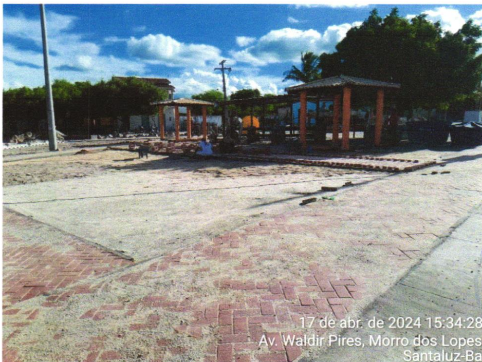
Foto 10 - Pavimentação em bloco de concreto vibroprensado, intertravado, colorido, 10x20cm, e=6cm, 46un/m 2 , NBR9781, Fck(min)=35MPa, sob coxim areia grossa compactada c/ placa vibratória, e(comp.)=6cm, rejuntado c/ areia fina.
