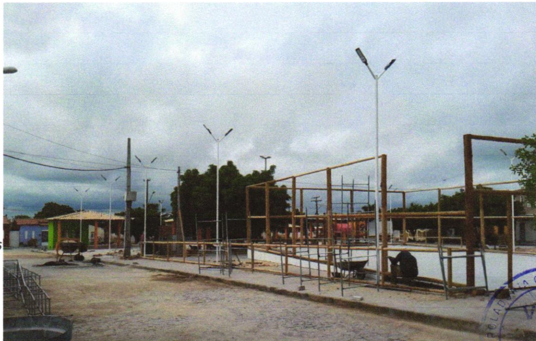
Foto 18 - Poste decorativo 2 pétalas, em aço galvanizado com difusor em vidro transparente temperado, com 3m/4m, inclusive lâmpada de led 50w
