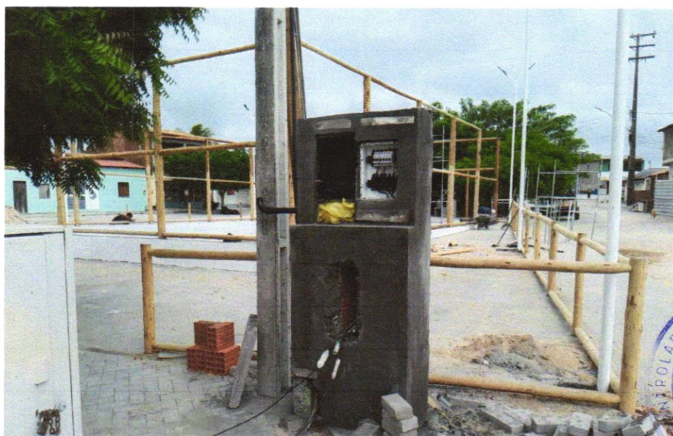
Foto 16 - CAIXA DE MEDIÇÃO DIRETA ATÉ 200A CONFECCIONADA EM CHAPA GALVANIZADA E PINTADA ELETROSTÁTICAMENTE D=100X60X15 CM
