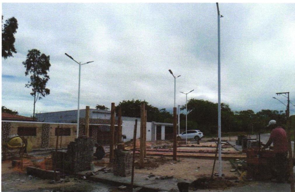
Foto 15 - LUMINÁRIA EM LED PARA ILUMINAÇÃO PÚBLICA, 30W, BIVOLT, SELO A INMETRO, CORPO EM ALUMÍNIO INJ, FP 0,97, PROT. DPS 10KV, IP66, IK09, TEMP. COR 5000K, IRC= OU 70%, V. ÚTIL 50.000H, 120 LM/W. GAR. 5 ANOS, MODELO GL216 G-LIGHT OU SIMILAR - REV 01
